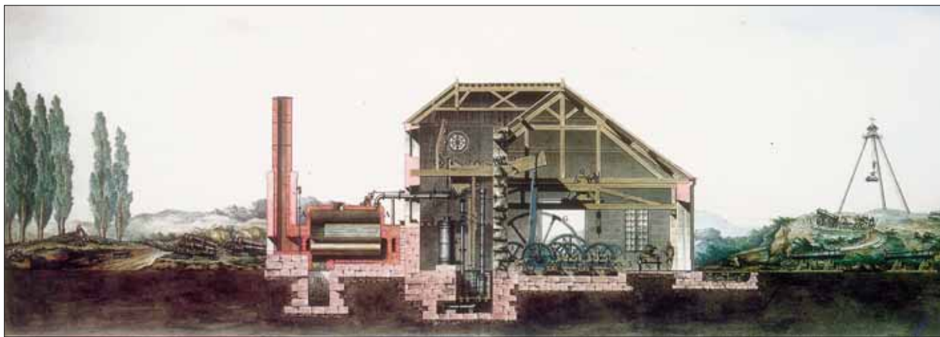
Interior del edificio con la máquina para barrenar cañones. "Descripción del establecimiento de Yndrid...", A. Betancourt, 1791. BPR.
